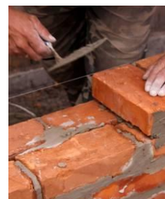
Рис. 24 Стена в один кирпич
