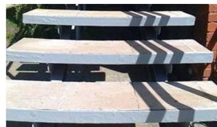
После грунтовки и покраски
