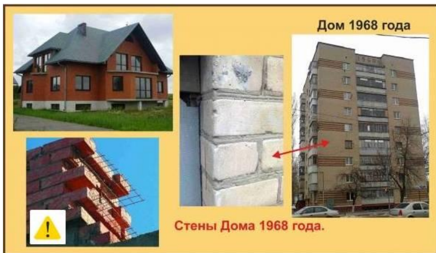
Рис. 23 Девятиэтажка из силикатного кирпича г.Белгород (Картинка сделана в 2013 году. Дому тогда уже было 45 лет, а он и не думал разрушаться. А морозостойкость у него 50 циклов)
