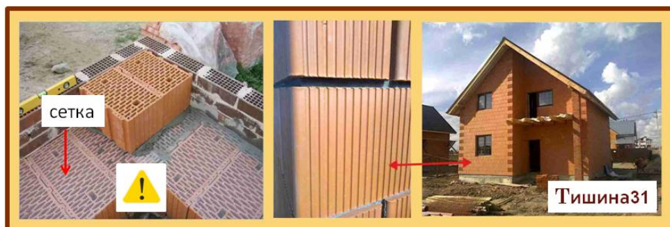
Рис. 20 Работа с керамическим блоком
