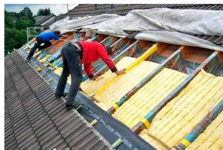
Рис. 29 Утепление крыши мин.ватой и пароизоляционной пленкой.
